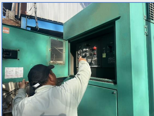
発電機メンテナンスの様子
