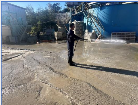
敷地内での散水
